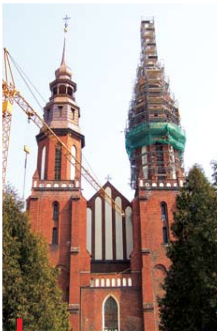
Remontowane wieże opolskiej katedry PONIŻEJ: Wolontariuszki rozdające ulotki z prośbą o przekazywanie 1% podatku
