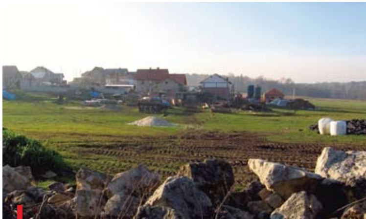
W Balcarzowicach odbudowa szybko postępuje. O bok: Grażyna Sprancel przed budowanym nowym domem
