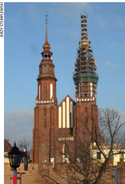
Trwa remont drugiej wieży
