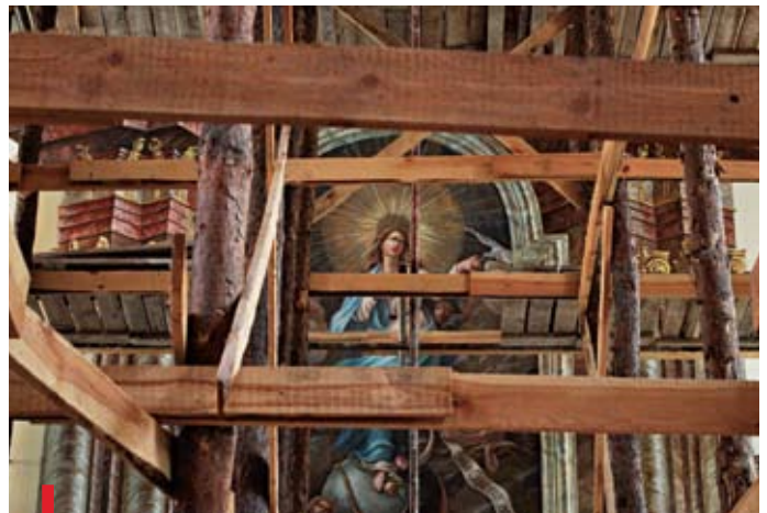
Renowacja ściany ołtarzowej w kościele filialnym
